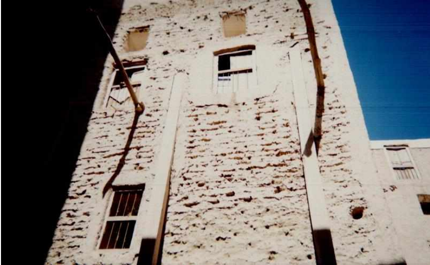
شكل رقم ٣- ٢٥ يوضح تقوية المباني الطينية
