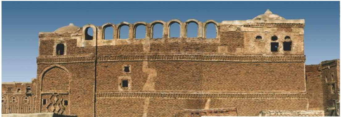
شكل رقم ٩-١ يوضح بعض التصدعات نتيجة لفقدان الصيانة الدورية والوقائية [20F]
