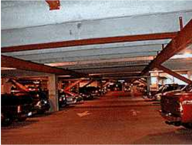
شكل ٣-٤ يوضح طريقة تدعيم الجسور بإضافة جسور معدنية
