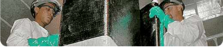
شكل رقم ٣-٣١ يوضح عملية إضافة ألياف حول عمود خرساني
