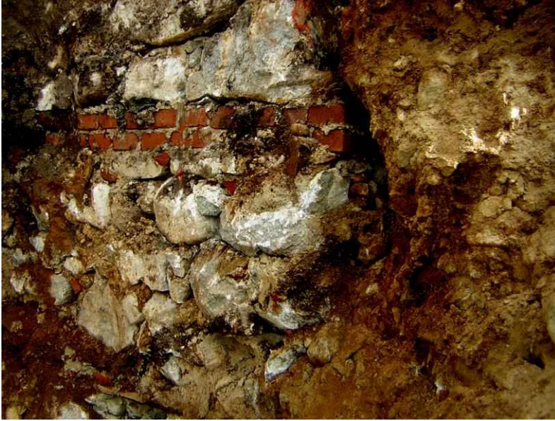
شكل رقم ١٥-٣ يوضح مدى تفكك الأساس قبل التوسعة في الإتجاه الرأسي
