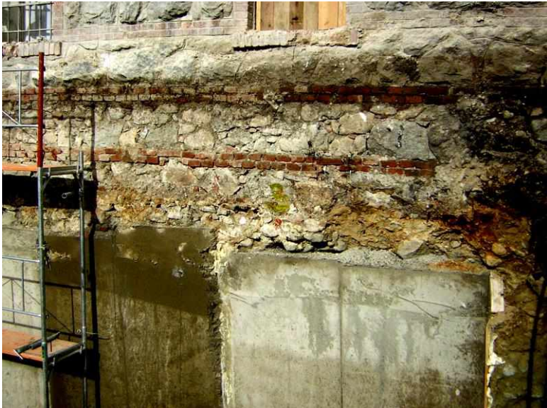
شكل رقم ٣-١٦ يوضح عملية ترميم الأساس بالتقوية الرأسية
